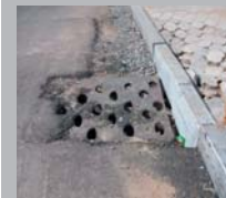
Улучшение / ремонт существующей дренажной системы
