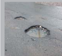
Ремонт поврежденных поверхностей
